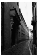
Giulio Minoletti, Giuseppe Chiodi Complesso edilizio sull'area dell'ex Palazzo Borromeo (1951-1954) via San Maurizio 21-25
